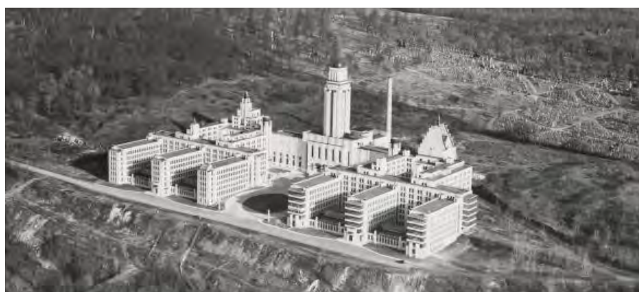
Mid-construction, L'Université de Montréal, Montréal, Québec, 1945
