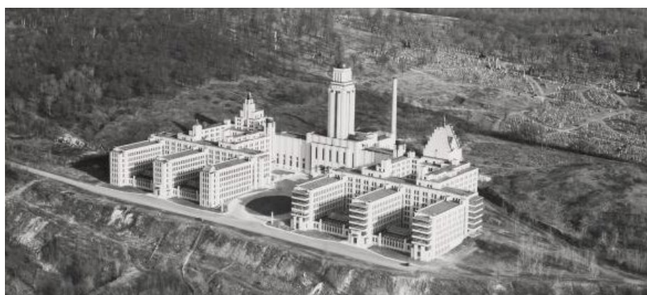
L'Université de Montréal, mid-construction, Québec, 1945
